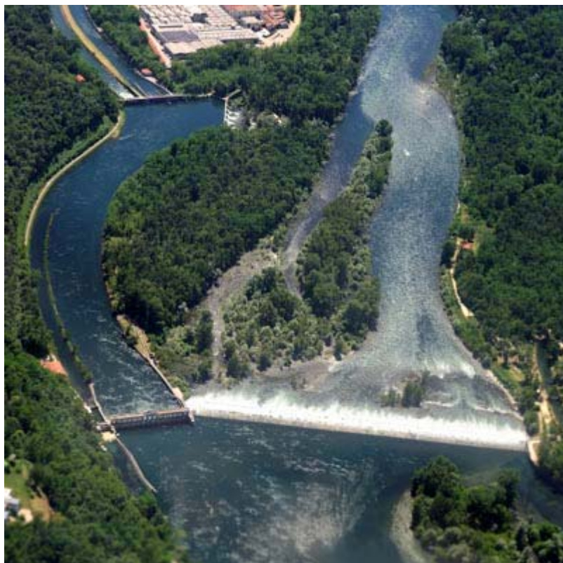
Le Dighe del Panperduto viste dall'alto
