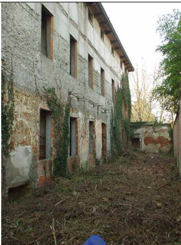
Vista lato Nord
