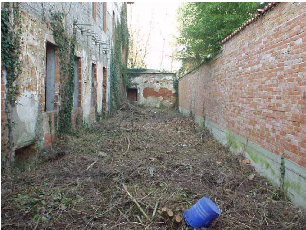
Vista cortile interno – Lato Nord
