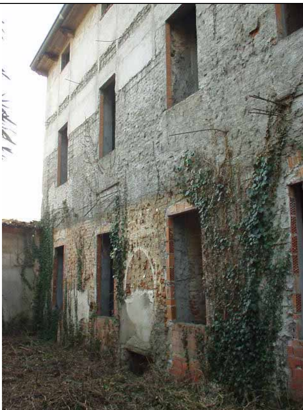
Vista lato Nord
